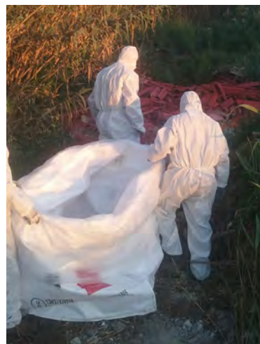
Sopra e a destra: operatori con indosso speciali tute rimuovono l'amianto abbandonato in discariche abusive
