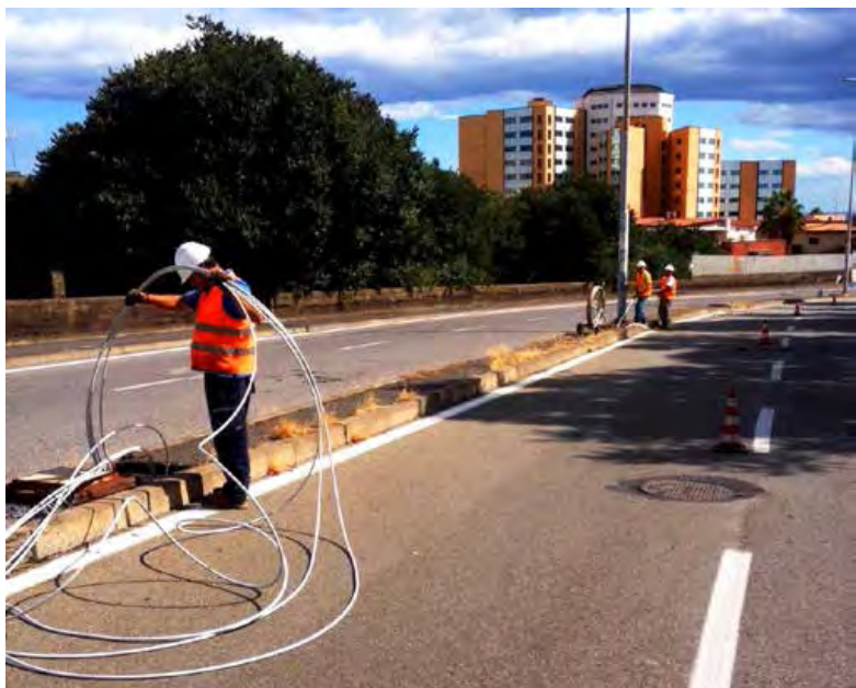
Sopra: un intervento di sostituzione dei cavi di rame rubati con quelli in alluminio per ripristinare la pubblica illuminazione
