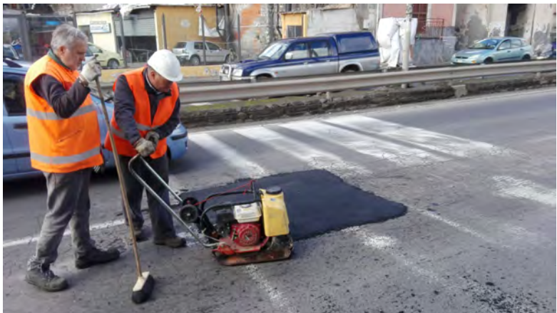
Sopra: strada riparata con la tecnica del tappetino d'asfalto
