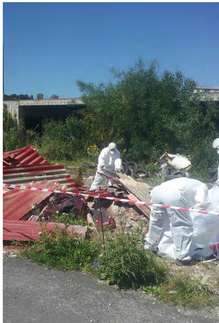
Sopra e a destra: operatori con indosso speciali tute rimuovono l'amianto abbandonato in discariche abusive
